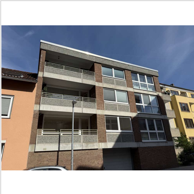
Balkon in südlicher Ausrichtung
