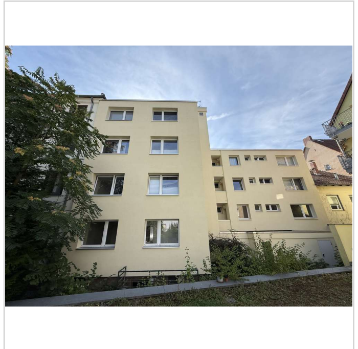
Rückansicht gedämmte Fassade
