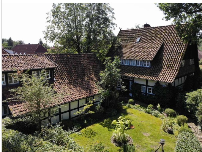
Ansicht Nord m. Anbau
